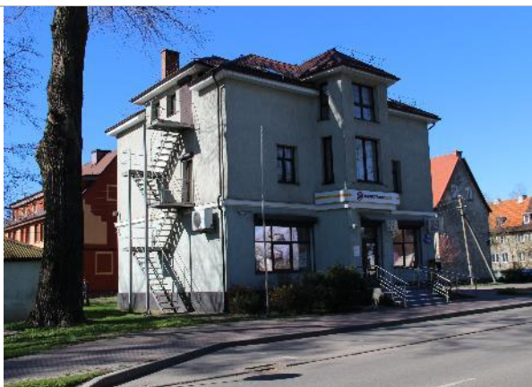
Фотография 3.1. Внешнее состояние объекта
