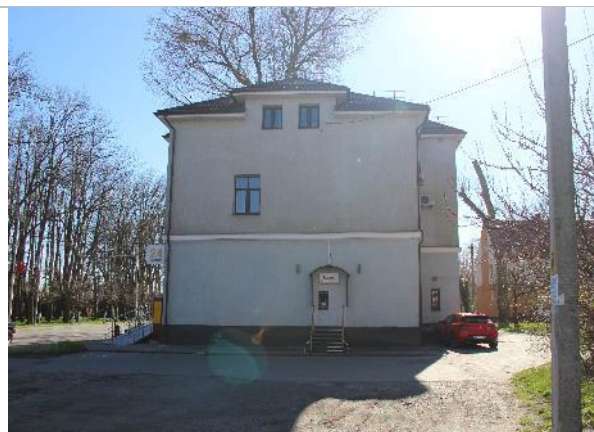
Фотография 3.2. Внешнее состояние объекта
