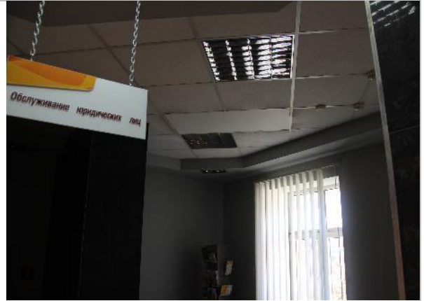
Фото 14. Внутренние помещения объекта.
