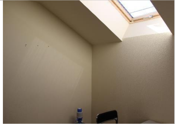
Фото 26. Внутренние помещения объекта.
